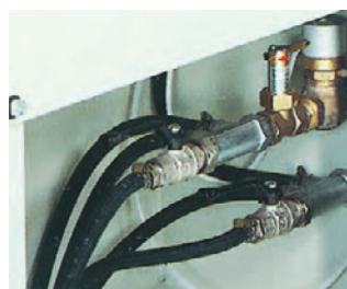
Ventil vodního okruhu a senzor průtoku chl. média 8230
